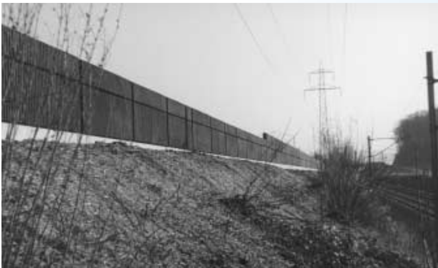
Abb. 1: Lärmschutzdamm mit Wand entlang einer stark befahrenen SBB-Strecke.
