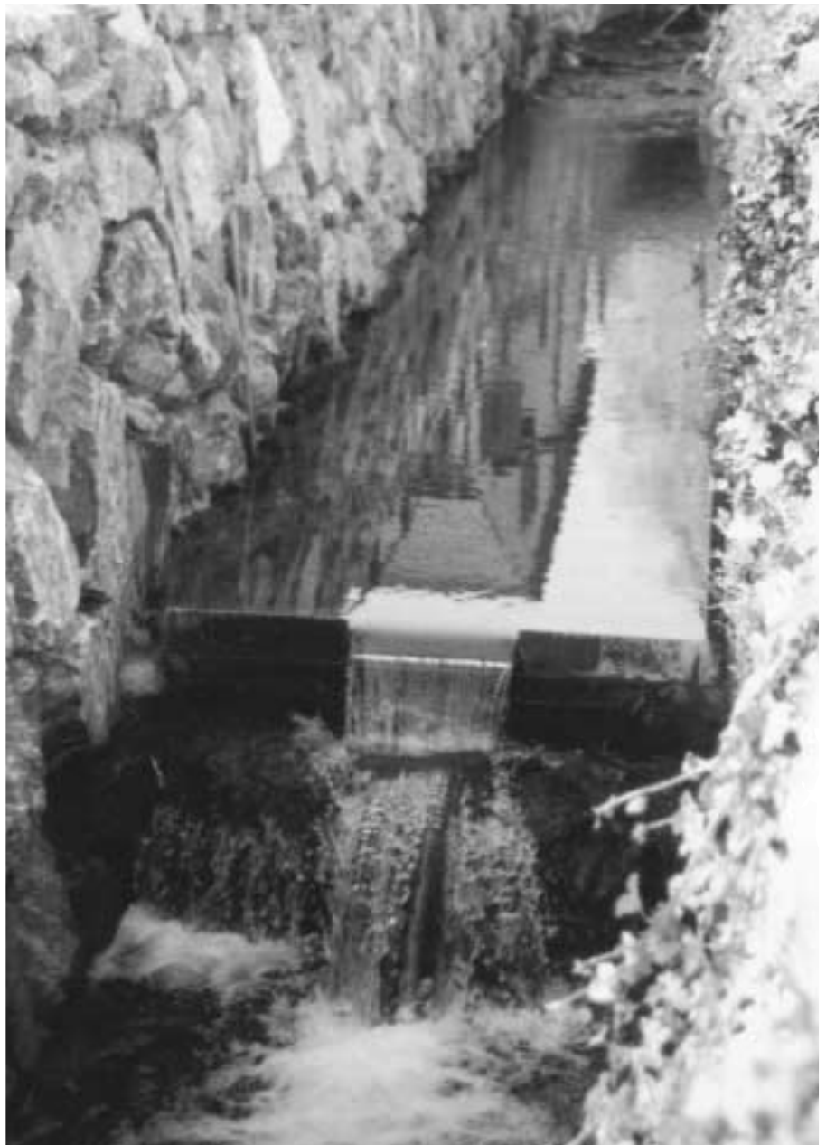
Abflussmess-Station an einem kleinen Bach.
