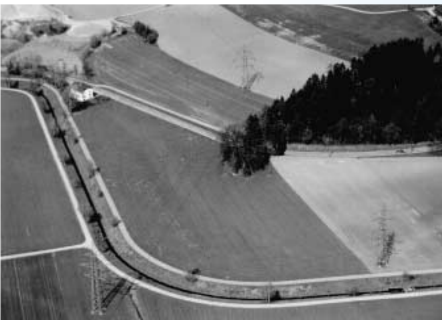
Zustand des Projektgebietes vor der Umgestaltung: Der kanalisierte Chrebsbach fliesst eingezwängt zwischen Veloweg und Flurweg
