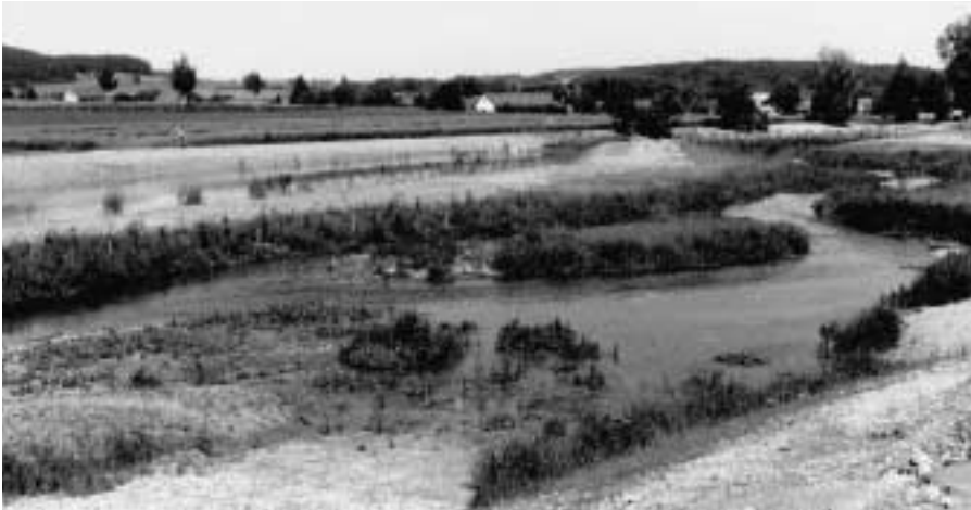
Nach der Revitalisierung: Der aufgeweitete, abwechslungsreich gestaltete Chrebsbach mit wechselfeuchten Zonen, Hinterwasserbereichen und unterschiedlichen Sohlenstrukturen.
