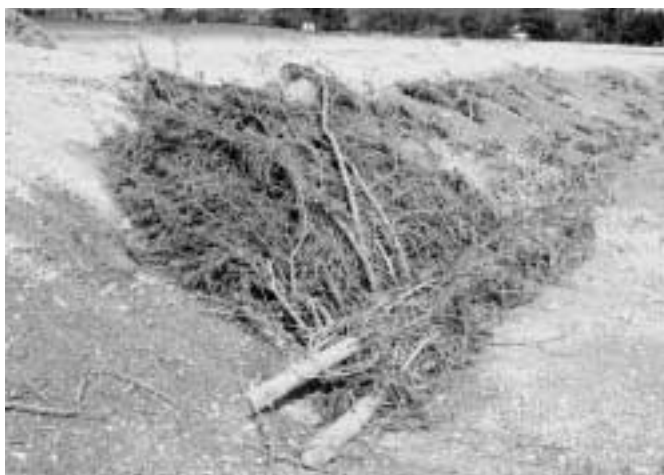
Ingenieurbiologische Massnahme: Tote Faschine am Böschungsfuss und Spreitlage auf der Böschung (ausgeführt durch die Unterhaltsgruppe Hettlingen des AGW); rechts: gleiche Stelle ca. ein halbes Jahr später. Die Faschinen wurden hinterpflanzt mit Erlen und Eschen.
