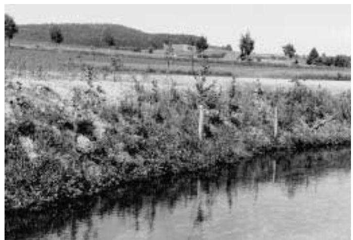
Ingenieurbiologische Massnahme: Tote Faschine am Böschungsfuss und Spreitlage auf der Böschung (ausgeführt durch die Unterhaltsgruppe Hettlingen des AGW); rechts: gleiche Stelle ca. ein halbes Jahr später. Die Faschinen wurden hinterpflanzt mit Erlen und Eschen.
