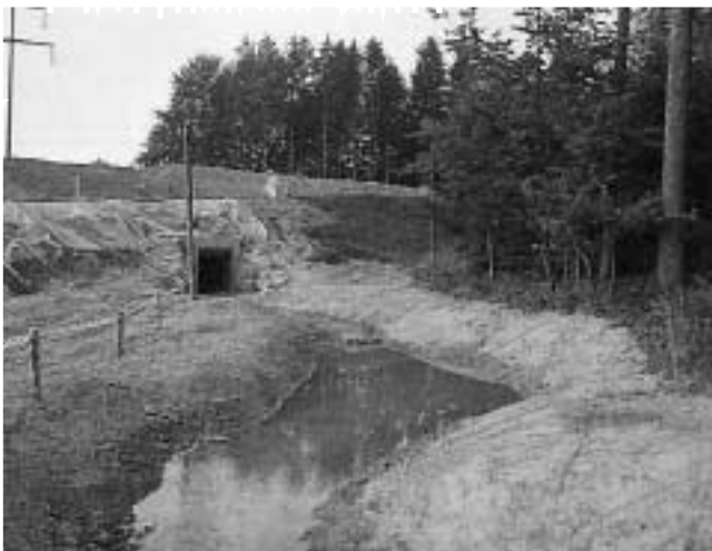
Abb. 18: Neuer Bachlauf Winterthurerstrasse Ost und der Durchlass unter der Winterthurerstrasse kurz nach der Fertigstellung (Aufnahme April 1984).
