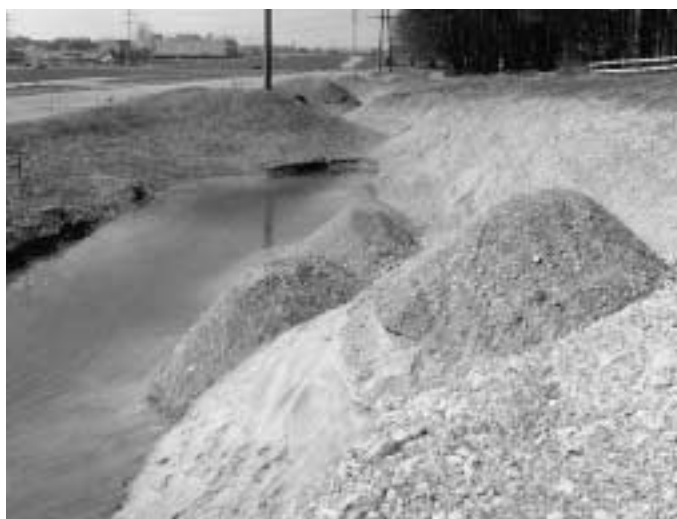
Abb. 14: «Zimiker Eichli»: Neugestaltetes Kleinrelief mit Grundwasserweiher und Steilböschungen (April 1984)...
