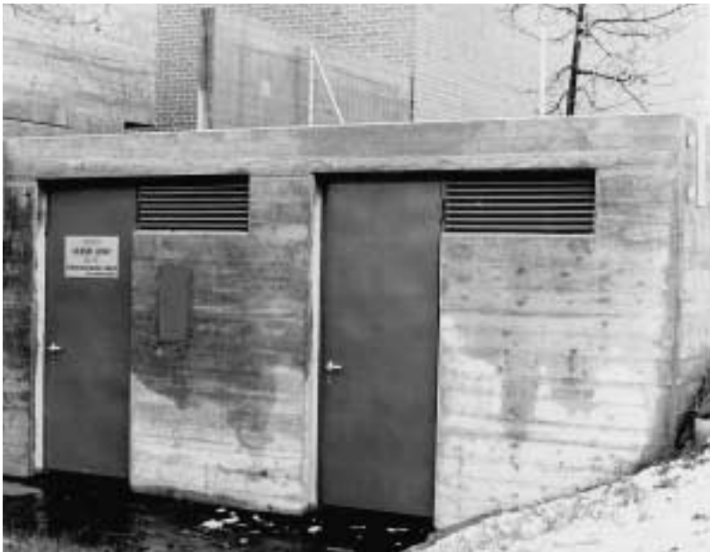
Getrennte Chemikalienräume (rechts der Lagerraum, links der Dosiererraum) mit direktem Ausgang ins Freie
