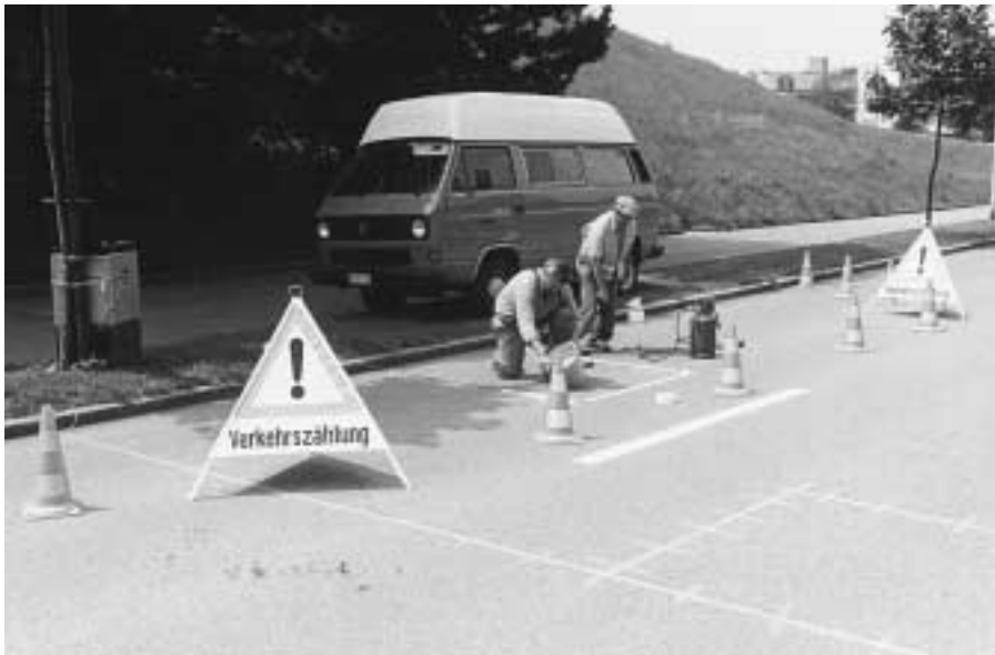
Eine Verkehrszählstelle wird eingerichtet
