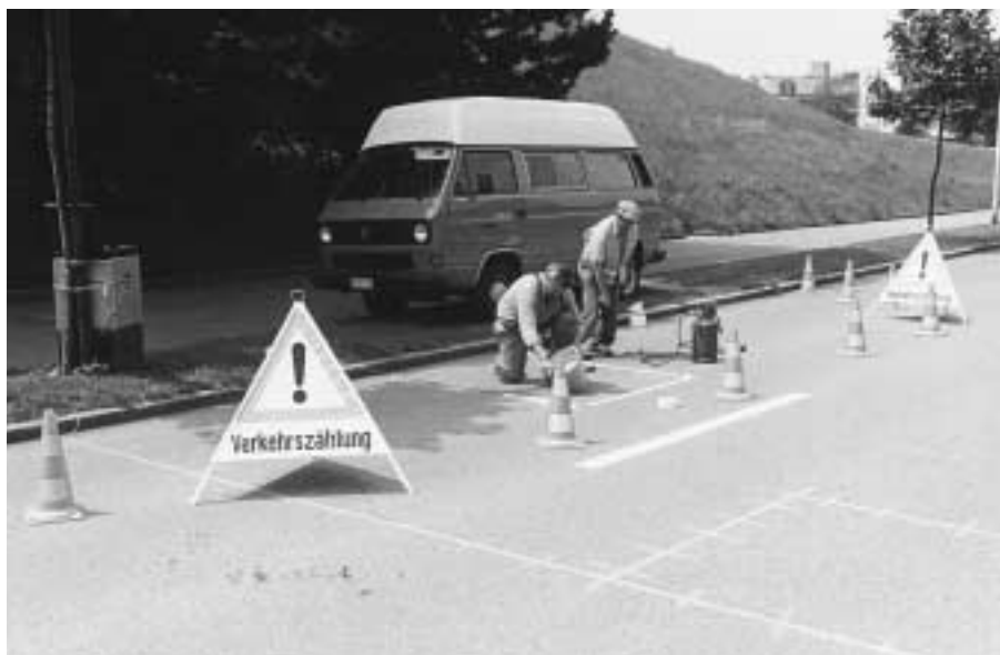
Eine Verkehrszählstelle wird eingerichtet
