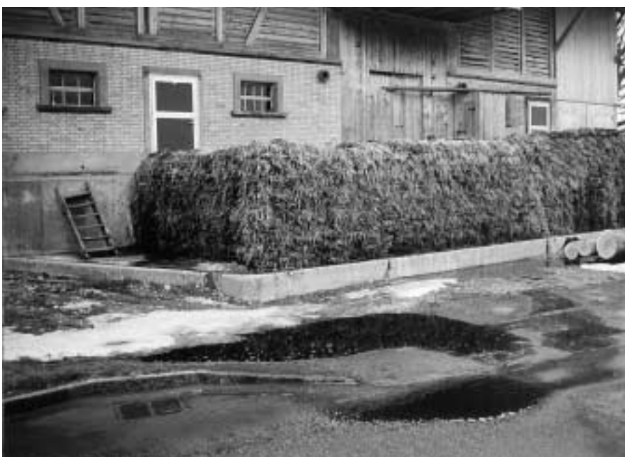
Abb. 3: Das Überlaufen von anfallendem Mistwasser in die nahegelegene Strassenentwässerung – ein oft wenig beachtetes Problem im Winter wie auch im Sommer (Quelle: BUWAL et al., 1988)
