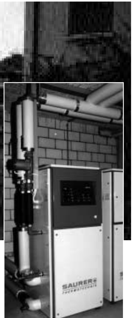
Wärmepumpen (kleines Bild) mit sogenannten Erdsonden als Wärmequelle liefern vor allem in neuen gut isolierten Ein- und kleinen Mehrfamilienhäusern den gesamten Wärmebedarf für Heizung und Warmwasser. Mit diesen Bohrgeräten (grosstes Bild) können auch bestehende Bauten mit Erdsonden nachgerüstet werden.
