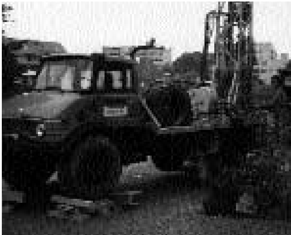
Wärmepumpen (kleines Bild) mit sogenannten Erdsonden als Wärmequelle liefern vor allem in neuen gut isolierten Ein- und kleinen Mehrfamilienhäusern den gesamten Wärmebedarf für Heizung und Warmwasser. Mit diesen Bohrgeräten (grosstes Bild) können auch bestehende Bauten mit Erdsonden nachgerüstet werden.
