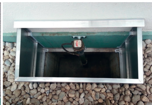
Bilder oben: Bei Zugängen ins Freie (z. B. Öffnung für Füllstutzen) ist zu verhindern, dass Wasser in den Tankraum gelangen kann.
