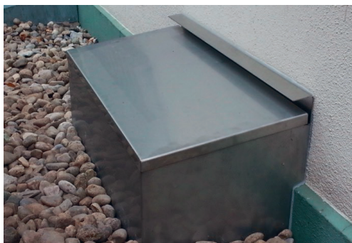
Bilder oben: Bei Zugängen ins Freie (z. B. Öffnung für Füllstutzen) ist zu verhindern, dass Wasser in den Tankraum gelangen kann.
