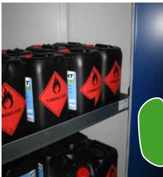
Brennbare Flüssigkeiten sind in speziellen Schränken aufzubewahren.
