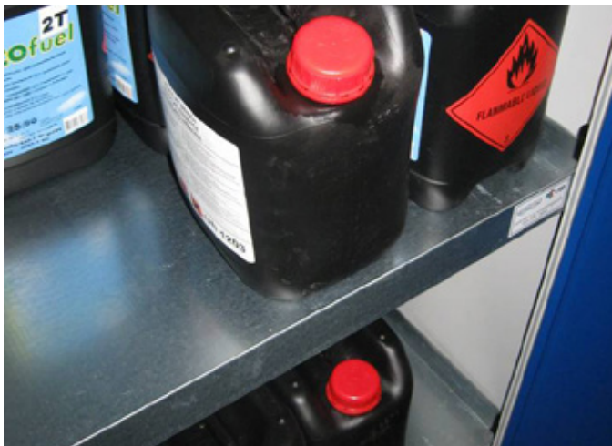
Entzündbare Flüssigkeiten müssen in einem nicht brennbaren Schrank mit Auffangwanne gelagert werden,...
