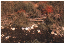
Mit Faschinen verbauter Abschnitt eines renaturierten Bächleins
