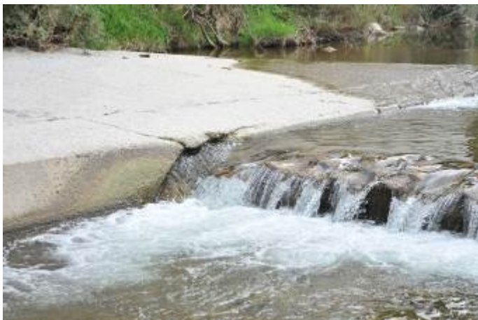
Foto 2. Die Töss am selben Standort wie oben, eine etwa 60 cm hohe Schwelle verhindert dem Biber das Aufwärtswandern in den Oberlauf der Töss. Mit einem einfachen Bibersteg könnte hier (und anderswo) die Durchgängigkeit für den Biber hergestellt werden.
