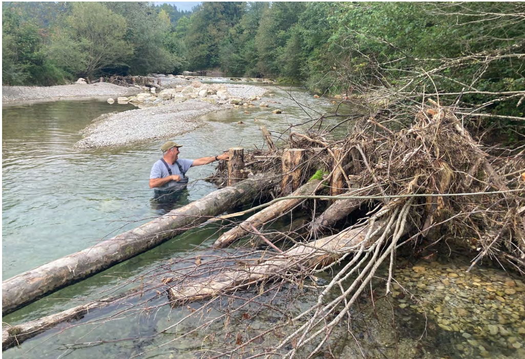
Abb. 13: Bereits nach kurzer Zeit zeigen die Totholzstrukturen in der Töss ihre Wirkung. Im tief ausgespülten Gumpen fühlen sich die Fische besonders wohl. Bild ©FJV
