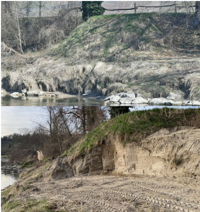
Abb. 9: Die im 2024 errichtete Sandschüttung (oben) wurde im März 2025 mit dem Bagger partiell senkrecht abgegraben.
