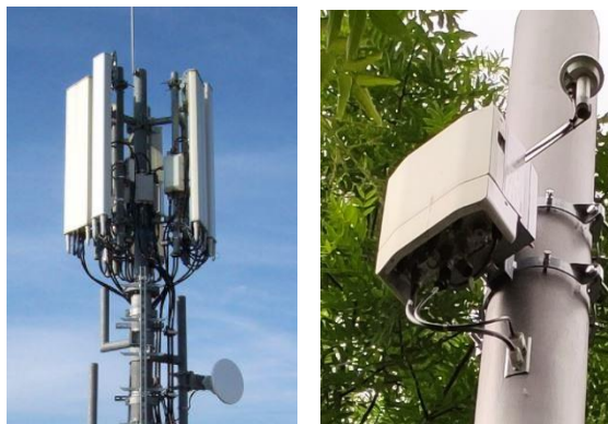
Abbildung 1: Links die Antennen einer Mobilfunk-Basisstation einer Makrozelle. Solche Sendeanlagen weisen Sendeleistungen von mehreren Hundert bis mehreren Tausend Watt ERP auf. Rechts die Antenne einer Kleinzelle mit einer maximalen Sendeleistung von 6 Watt ERP.
