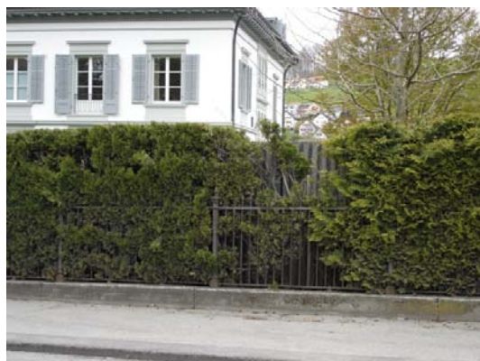
Bild 3: Rütistrasse 14 mit Lärmschutzwand hinter der Hecke.
