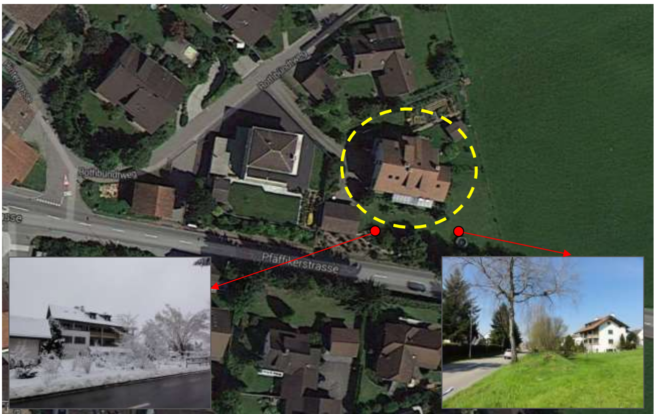
Bild 2 – Situation Abschnitt 28, Pfäffikerstrasse Uster
