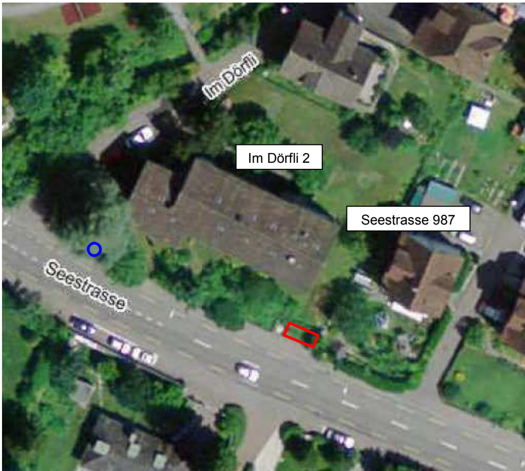
Abbildung 3.2 Luftaufnahme Situation Abschnitt 40, Meilen. Rot eingezeichnet ist das kleine Stück öffentlichen Landes. Blau eingezeichnet ist der Hydrant.
