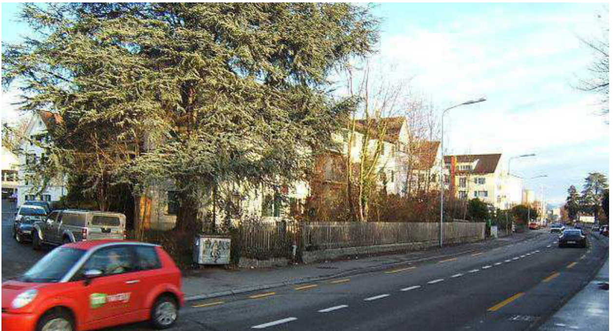
Abbildung 3.3 Übersicht Abschnitt 40, Meilen. Liegenschaft Im Dörfli 2 (hinter Baum).
