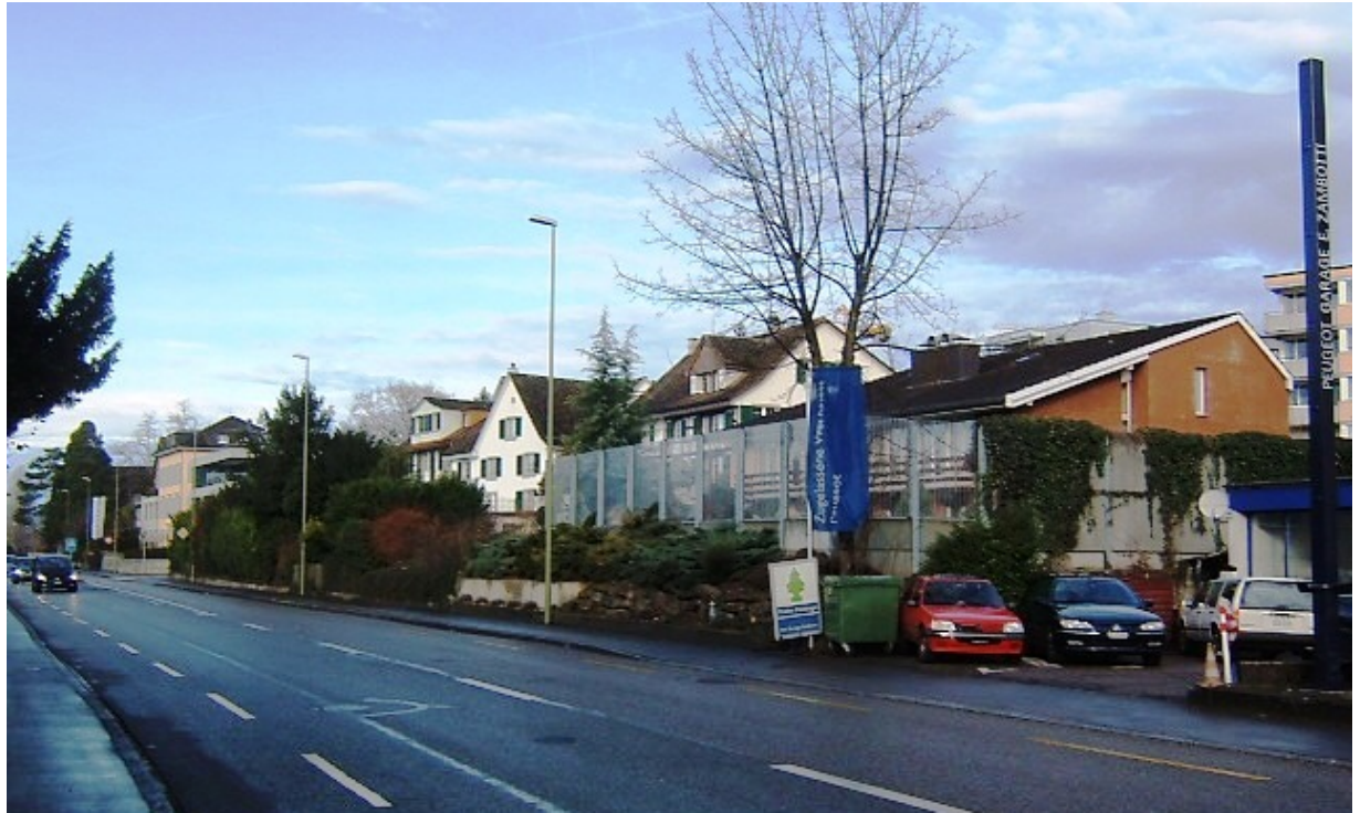
Abbildung 3.1 Situation mit bestehender Lärmschutzwand, Abschnitt 14
