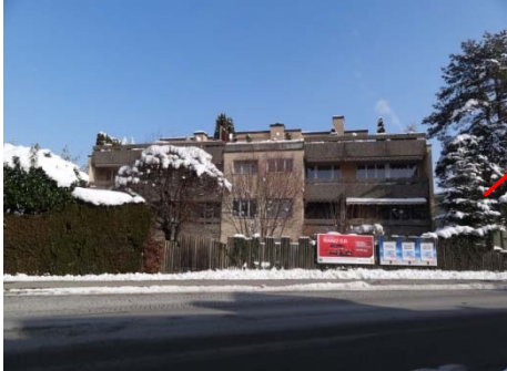
Bild 5: Stuhlenstr. 4 und Holzpalissade
