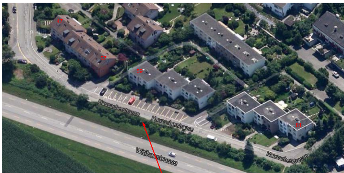
Bild 2: Situation (Luftbild) Abschnitt 2 West.
