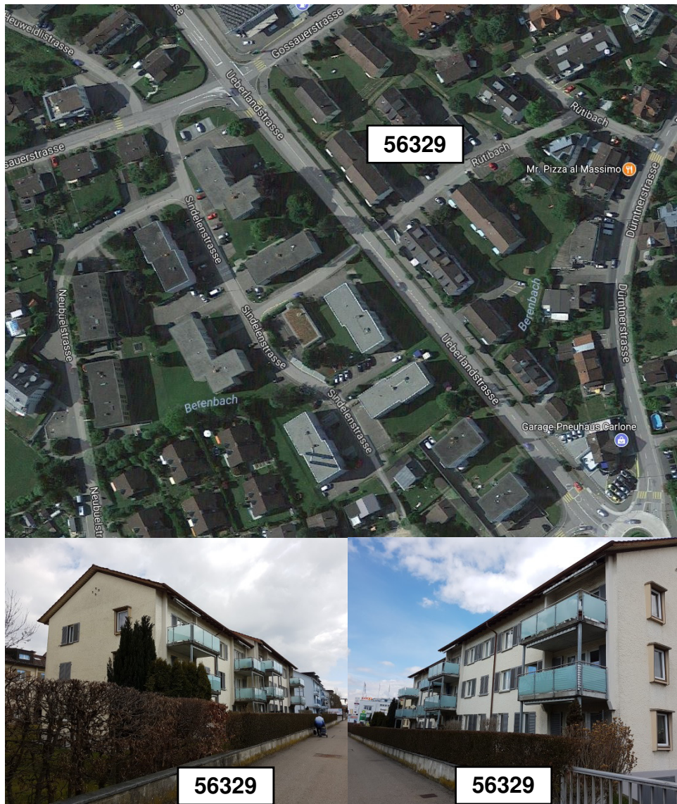
Abb 2 Betroffene Liegenschaft (Parzelle Kat. Nr. 1076), Abschnitt 23
