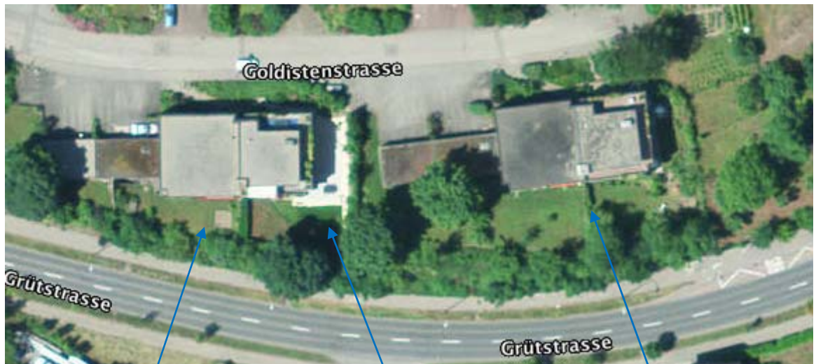
Bild 2: Situation (Luftbild) Abschnitt 25, Goldistenstrasse.
