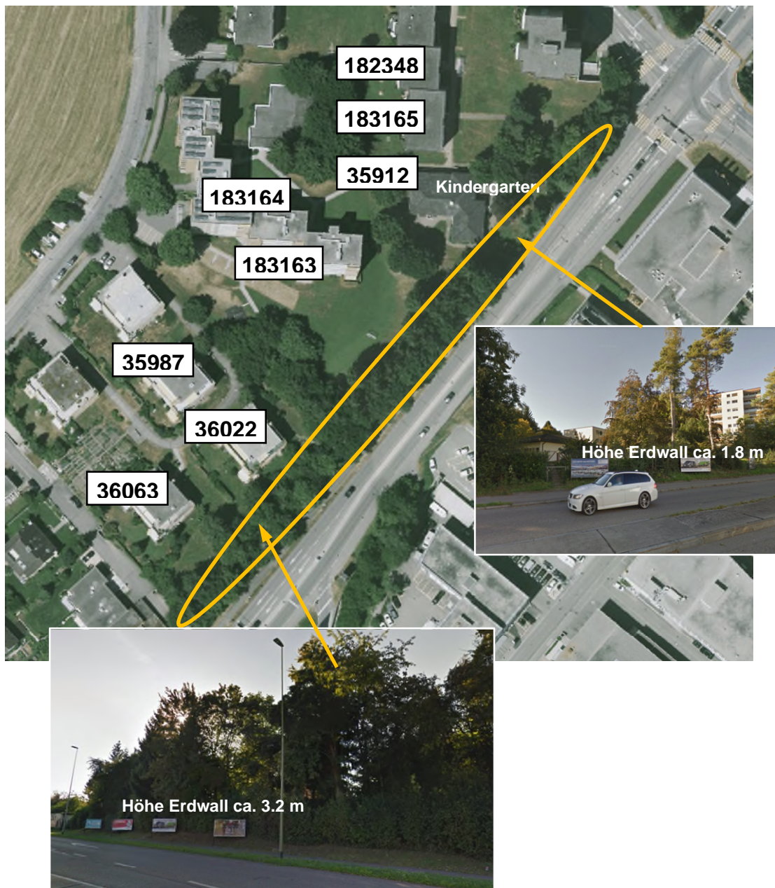
Abb 2 Betroffene Gebäude im Abschnitt 2
