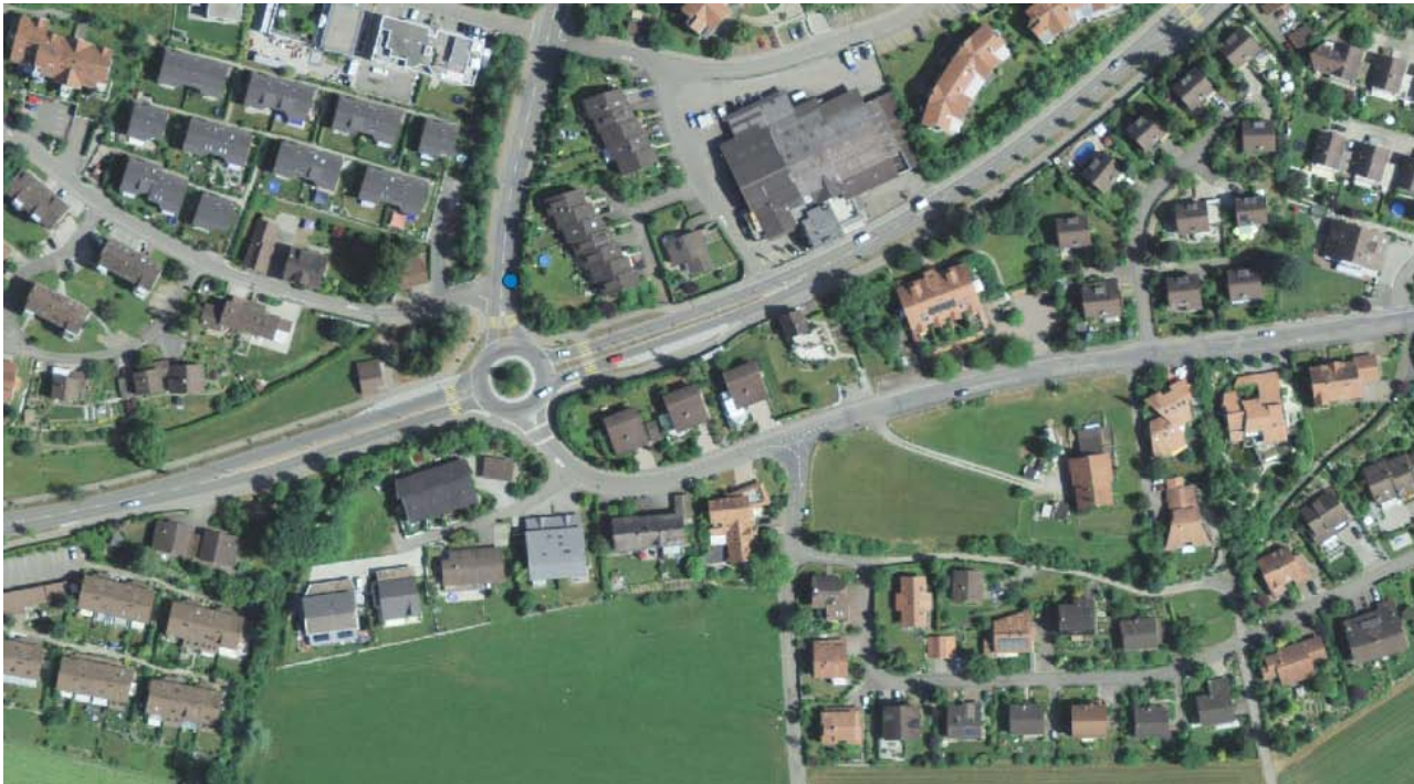
Bild 2 – Situation (Luftbild) Abschnitt 11 / 12, Landstrasse
