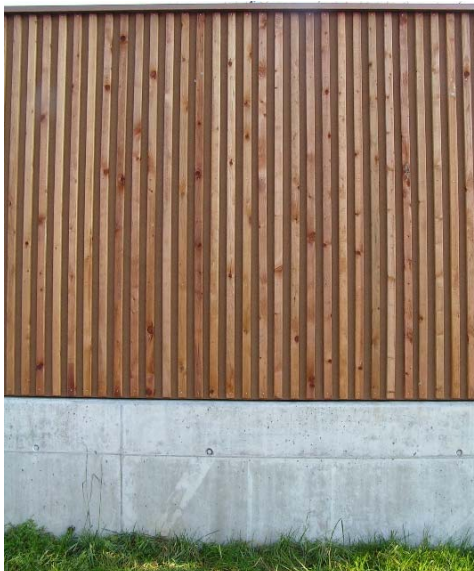
Referenzbilder: LSW aus Holz, vertikal mit Betonsockel; lärmabsorbierende Drahtschotterkörbe
