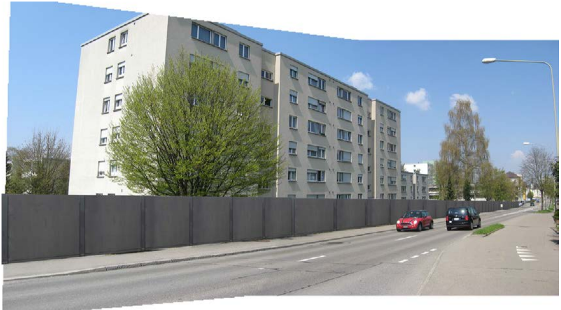
Bestehende Anlage mit projektierte LSW
