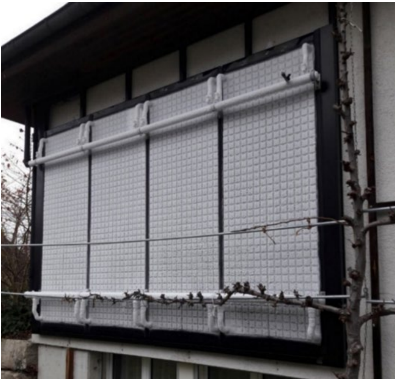
Abbildung 20 Solarabsorber am 28. November 2020, nach 5 Tagen ohne Sonne und Temperaturen um den Gefrierpunkt. Ob die Hinterseite ebenfalls vereist ist, ist nicht bekannt.
