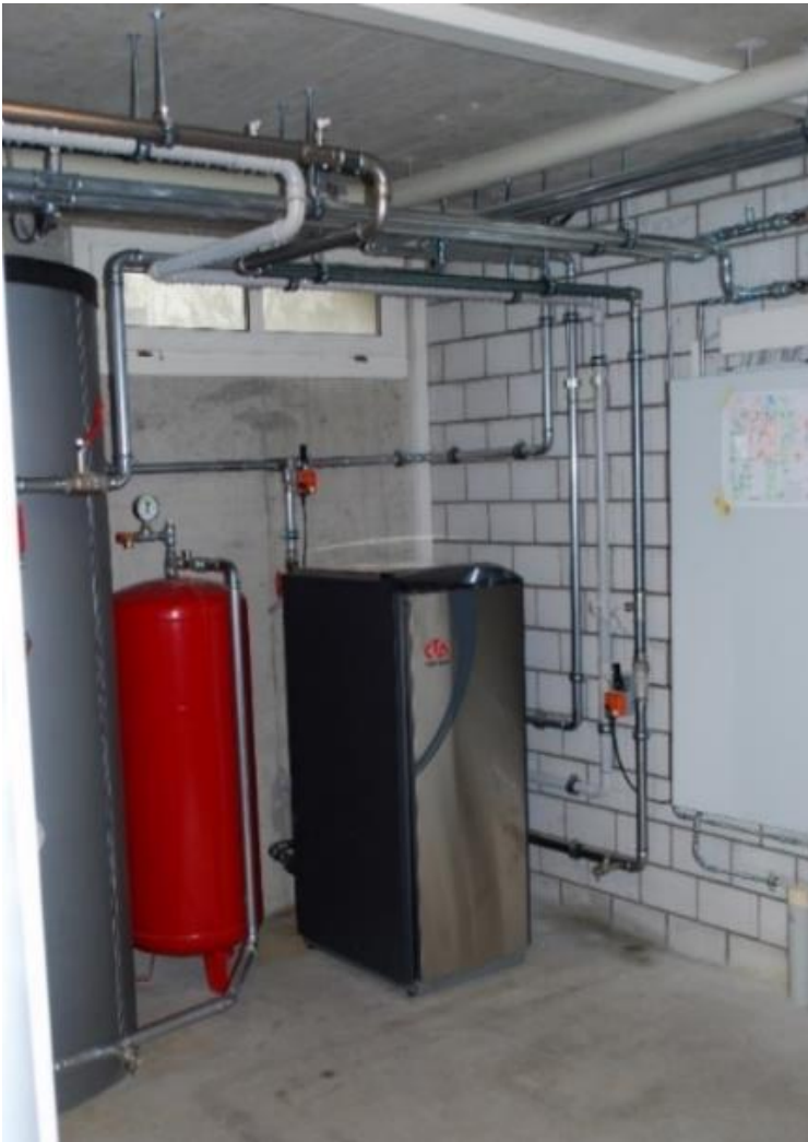
Abbildung 8 Wärmepumpe CTA Optiheat All-in-one 1-8es.
