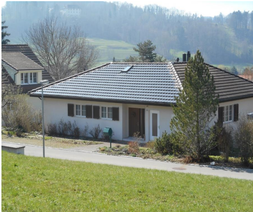
Abbildung 2 Einfamilienhaus Winzerstrasse 9, 8353 Elgg. Blick auf das Ostdach mit Panotron Solarziegeln.
