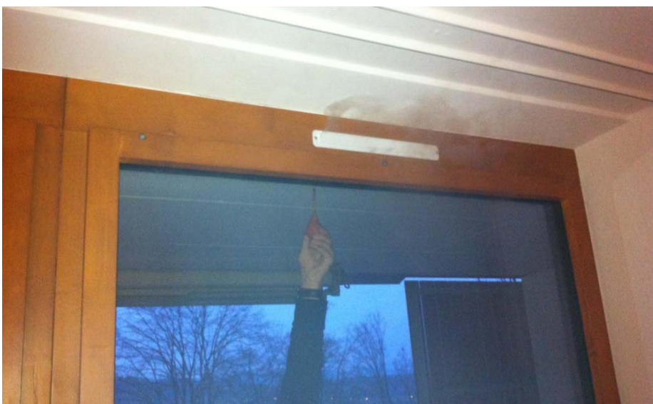
Abb. 6 : Rauchversuch am Aussenluftdurchlass im Wohnzimmer
