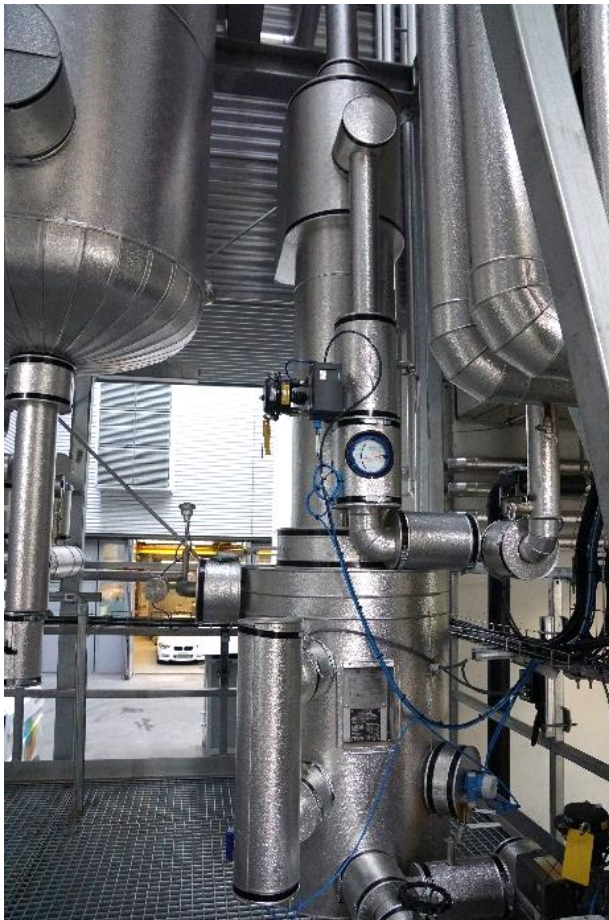
Abbildung 19: Waschkolonne [Limeco]
