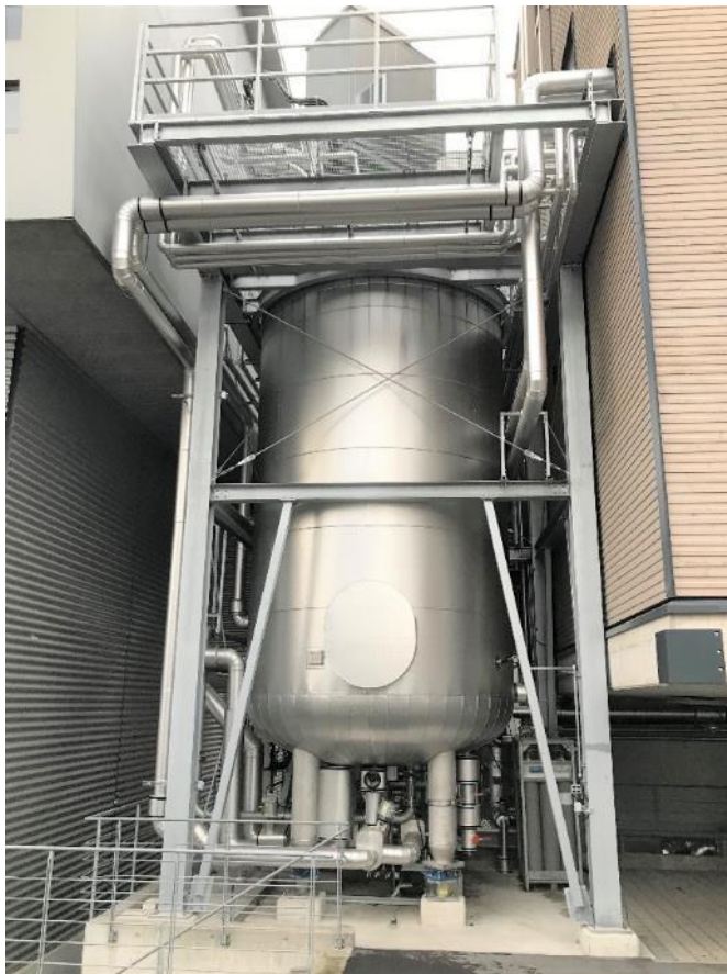
Abbildung 14: biologischer Methanisierungsreaktor [Limeco]
