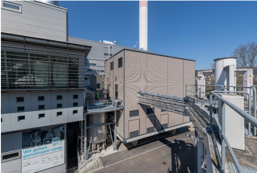
Abbildung 11: Die PtG-Anlage – Bioreaktor und Vollholzgebäude [Limeco]
