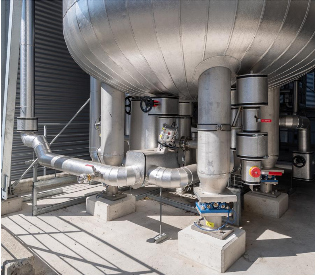
Abbildung 16: Unterseite des Bioreaktors stehend auf blauen Wägekomponenten [Limeco]
