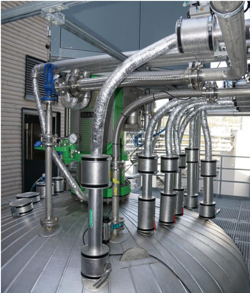
Abbildung 17: Oberseite des Bioreaktors [Limeco]
