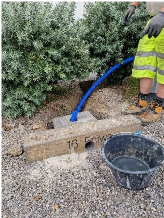
Abbildung 44: Installation des Leerrohrs beim ersten Ladestationsstandort
