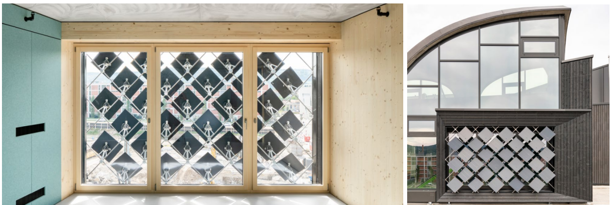
Adaptive Solarfassade in der HiLo-Unit; Fotos: Roman Keller
