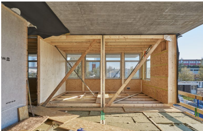
Sprint besteht aus vorfabrizierten Holzmodulen; Foto: Martin Zeller
