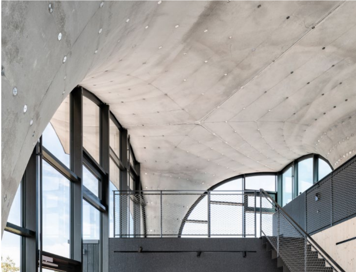
Doppelt-gekrümmtes Dach der HiLo-Unit; Foto: Roman Keller
