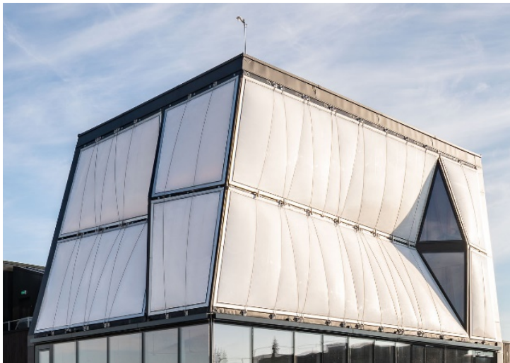
Transluzente Leichtbaufassade; Foto: Roman Keller
