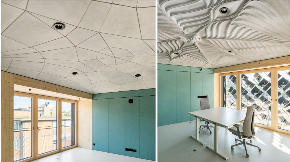
Die beiden Leichtbau-Bodensysteme in den Büros der HiLo-Unit; Fotos: Roman Keller
