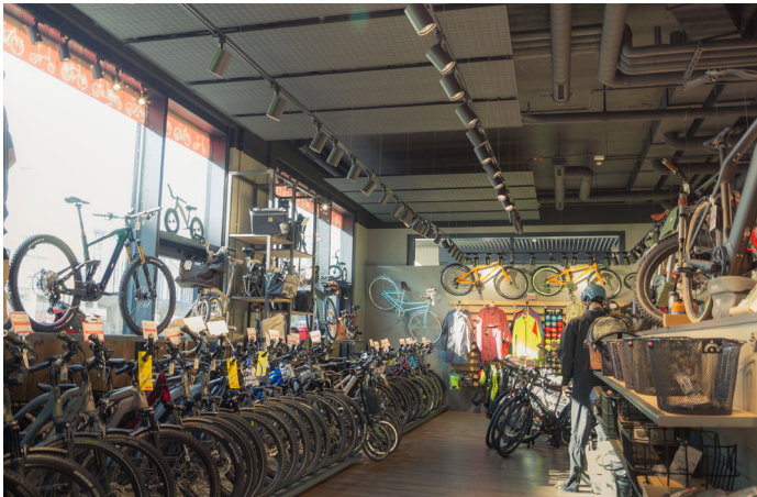
Durch Einsatz von Niedertemperatur-Wärmeabgabesystemen – im Bild eine Klimadecke – können Wärmepumpen mit hoher Effizienz betrieben werden. Foto: SOLTOP Energie AG
