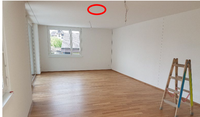
Abbildung 60: Wohnzimmer in mittlerer Wohnung Haus, rot markiert die Position des Temperaturfühlers in der Betondecke
