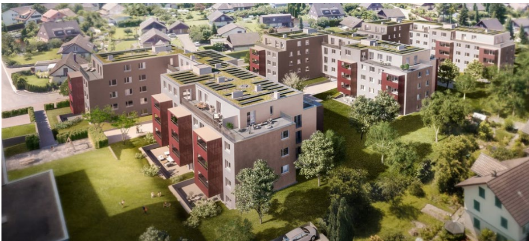
Abbildung 2: Vorne im Bild ist das Gebäude C zu sehen, in der Mitte das Gebäude B und im hinteren Bildteil das Gebäude A. Die zentrale grosse Technikanlage ist unterhalb des Gebäudes C platziert, die dezentralen Anlagen jeweils im Haus A und B.
