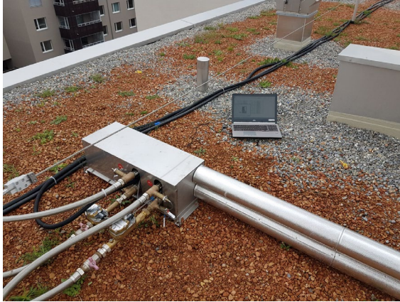
Abbildung 63: Wärmemengen –Messstellen der Solaranlage P&D Teil
