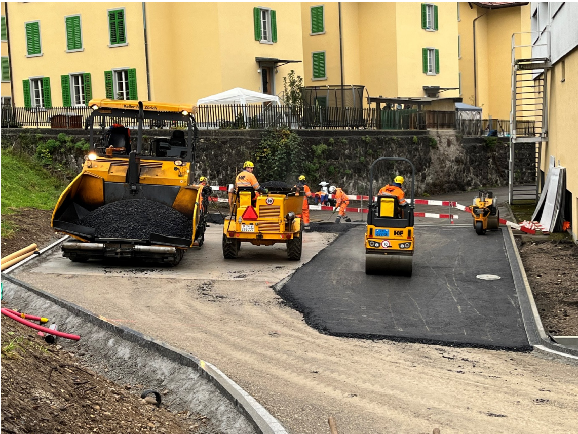
Abbildung 59: Asphaltierung
