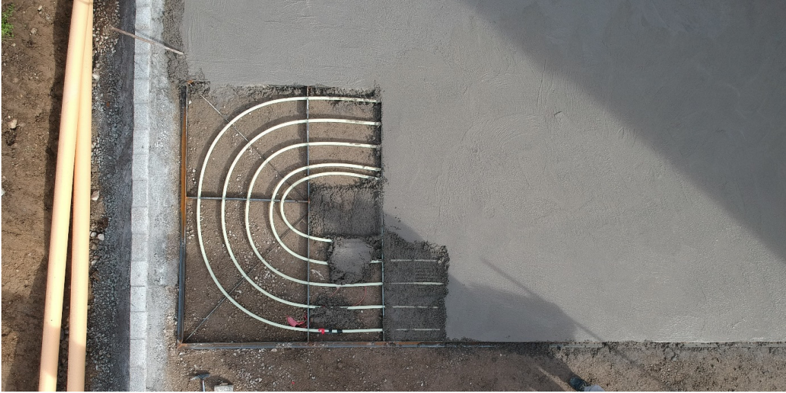
Abbildung 58: Drohnenaufnahme Asphaltkollektor
