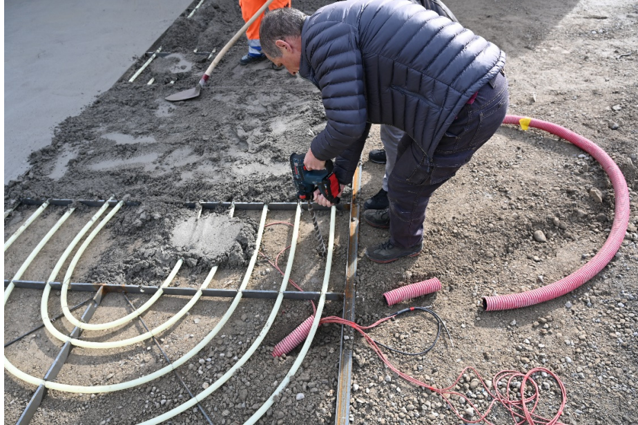
Abbildung 56: Bohrung der Löcher für die Temperatursensoren unterhalb des Asphaltkollektors
