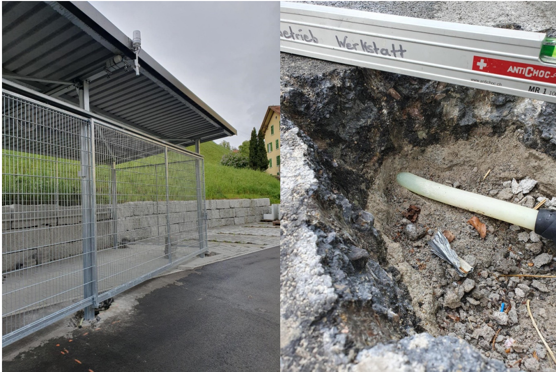
Abbildung 8: Links Wetterstation, Rechts: Loch im Asphalt zur Installation des Rohrlagers, wobei der Kollektor beschädigt wurde
