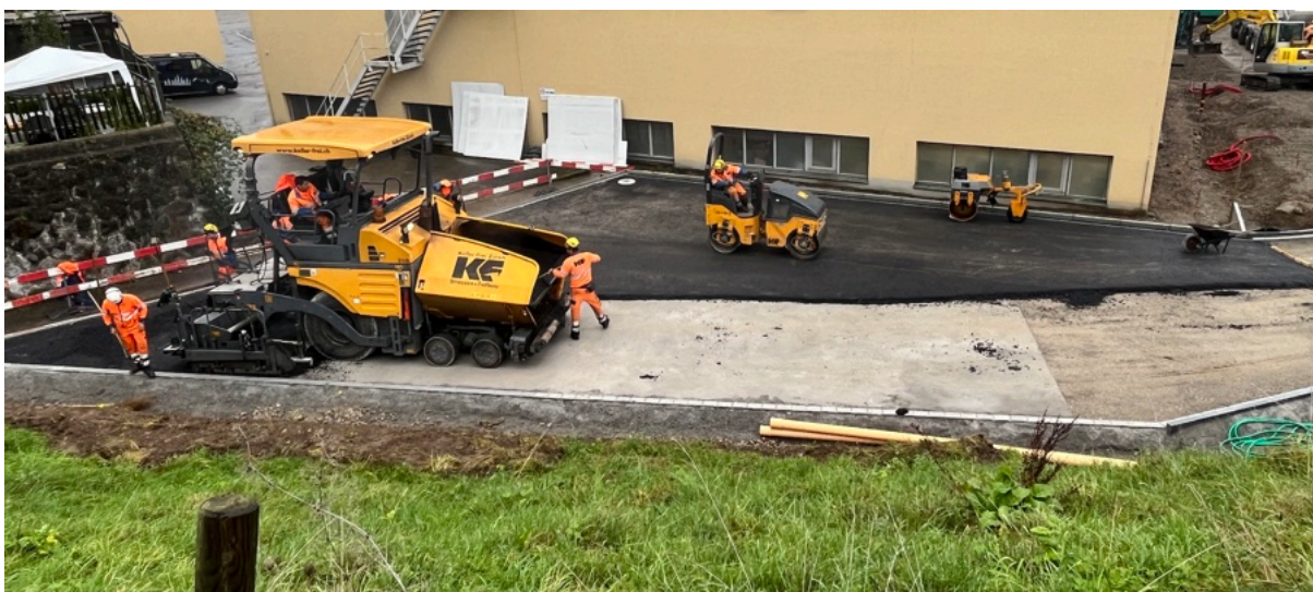
Bild 15: Die Asphalttschicht wird mit einem Strassenfertiger eingebaut.
