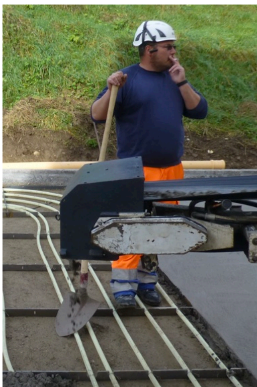
Bild 13: Die Rohre werden wenn möglich nicht belastet. Dank dem Abstand kann das Personal zwischen den Rohren stehen.
