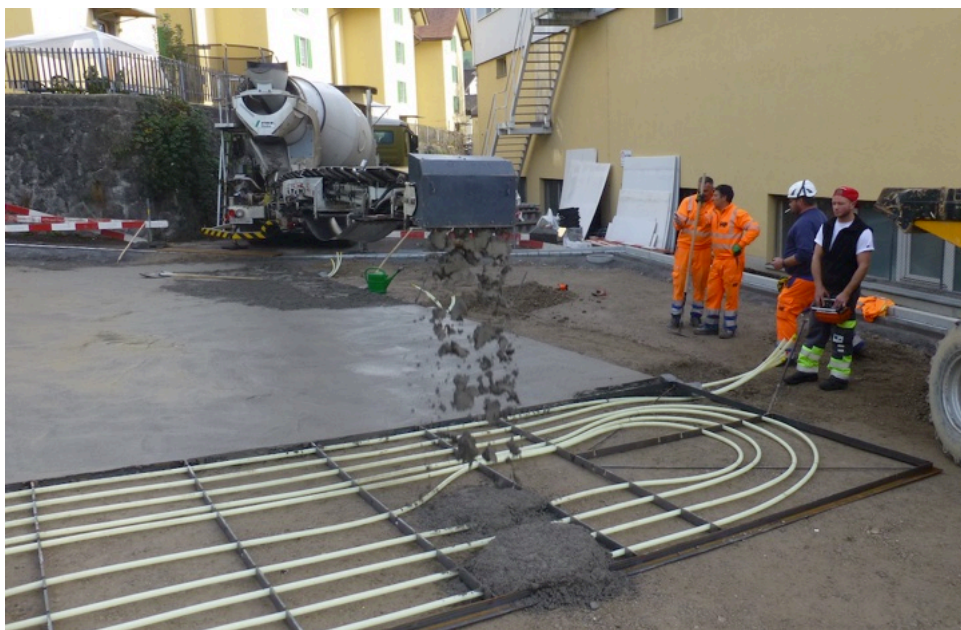
Bild 12: Einbringen des Zementmörtels mit dem Förderband
