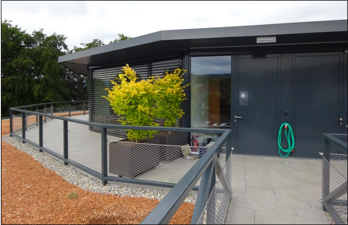
Abbildung 1-3: Dachgeschoss mit Eingang Technik und Fassade Büro (mit aussenliegenden Lamellenstoren).
