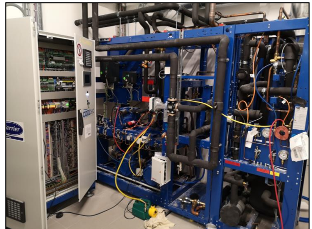
Abbildung 1-9: Kältemaschine Lebensmittelladen
