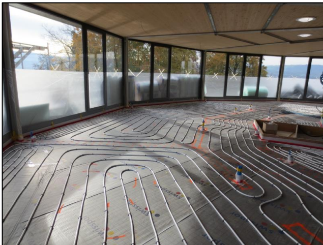
Abbildung 1-12: FBH im Dachgeschoss
