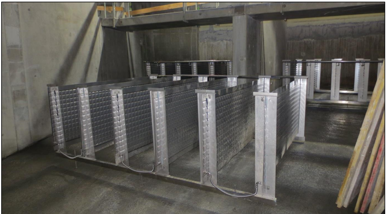
Abbildung 1-5: Einbau der Wärmetauscherplatten von Energie Solaire SA.
