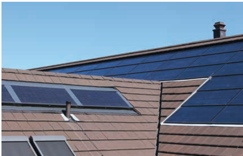
Minergie-A-Büro-/Wohnhaus mit Photovoltaikanlage und Hybridkollektoren zur solaren Vorwärmung des Brauchwarmwassers (Bild: Hässig Sustech).
