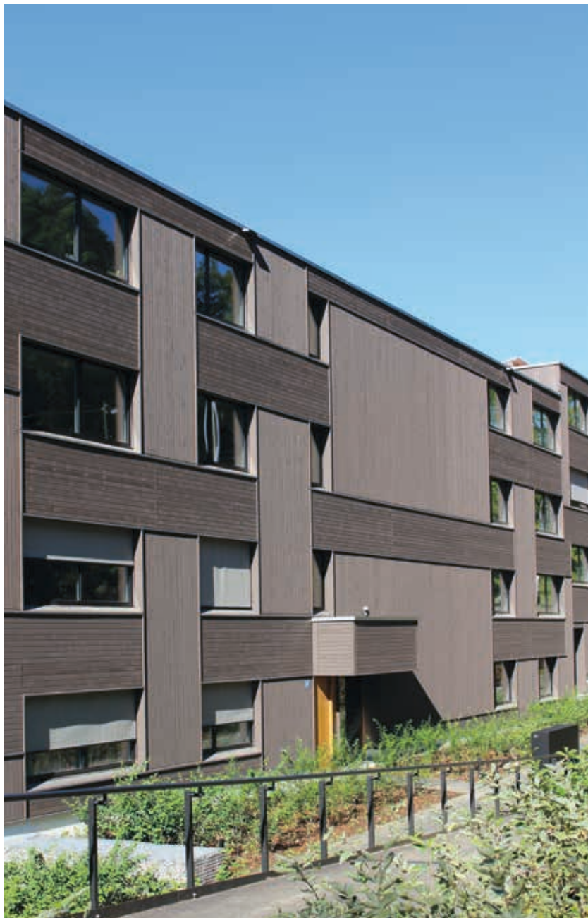
In den Mehrfamilienhäusern an der Tièchestrasse in Zürich wird die Effizienz von vier verschiedenen Erdwärmesonden-Wärmepumpen-Konzepten verglichen (Bild: AWEL).
