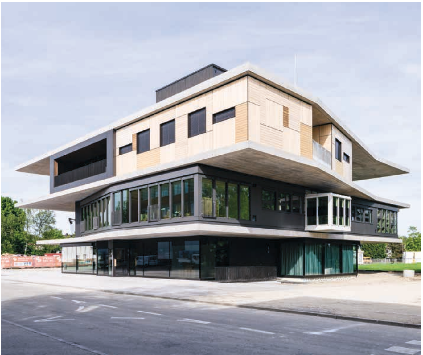
Aussenansicht NEST mit ersten eingebauten Units (Bild: Roman Keller).
