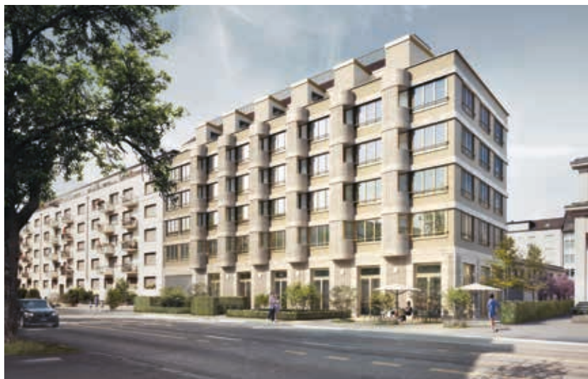
Das Pilotprojekt Hohlstrasse testet eine Aerogel-Wärmedämmung und Fenster mit Vakuumisoliationsverglasung auf ihre Praxistauglichkeit (Bild: Nightnurse Images).
