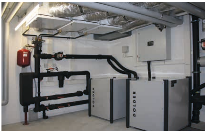
Für den Betrieb mit Abluft optimierte Wärmepumpe (Bild: Dolder Wärmetechnik).
