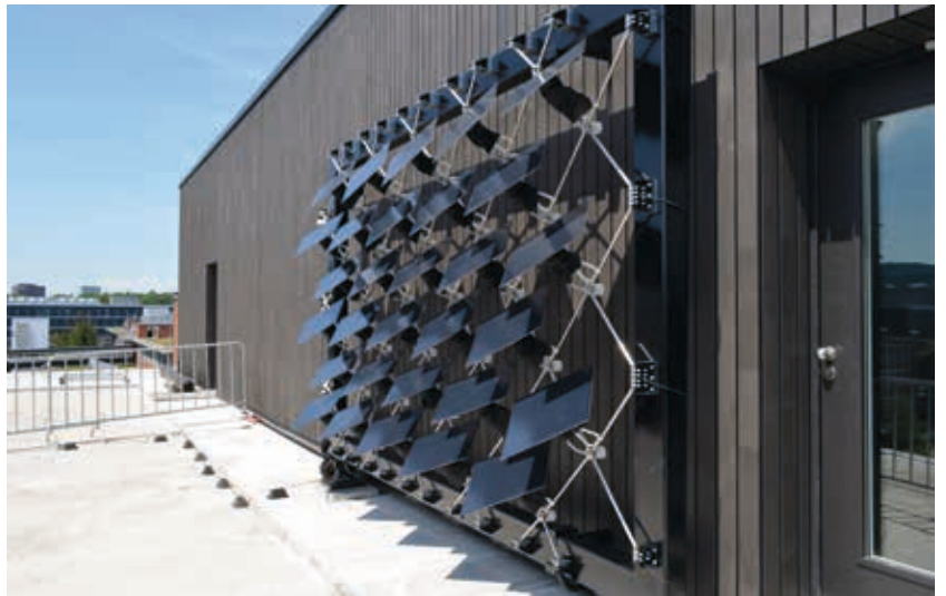
Adaptive Dünnschicht-Photovoltaikmodule (Bild: Empa).
