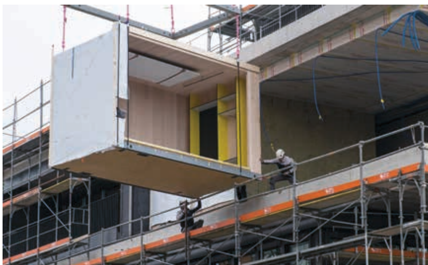
Einbau eines vorgefertigten Wohnraums (Bild: Empa).
