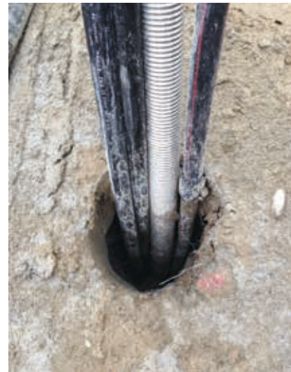
Vergleich unterschiedlicher Energiekonzepte mit Erdwärmesonden für Mehrfamilienhaus-Ersatzneubauten. Im Bild rechts CO 2 -EWS (Chromstahl-Wellrohr) mit Füllrohr und U-Sonde für die passive Kühlung im Sommer (Bild links: AWEL, Bild rechts: ewz).
