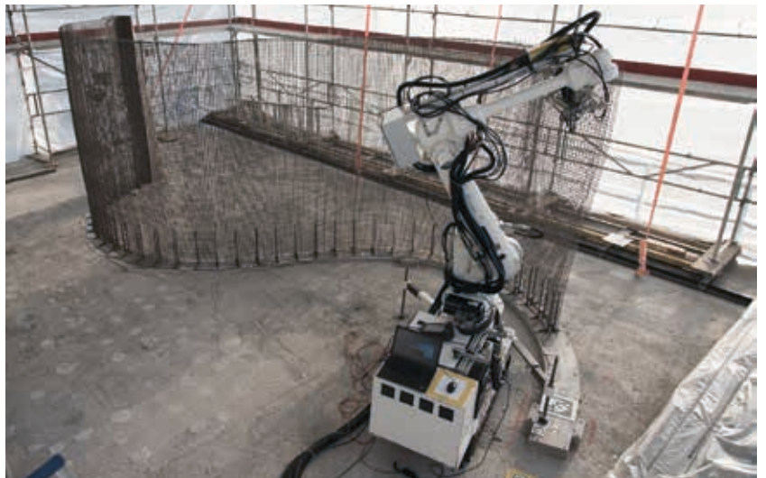
Automatisierte Vor-Ort-Fabrikation von Armierungen für schalungsfreie Betonwand (Bild: NFS Digitale Fabrikation).
