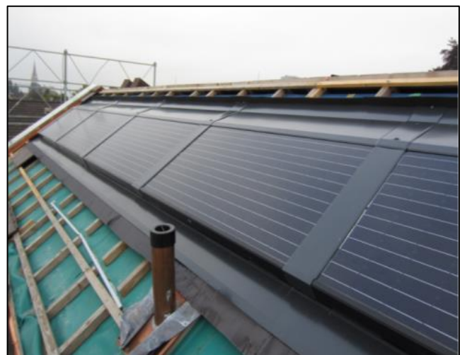
Abbildung 7, Einbau der PVT-Anlage
