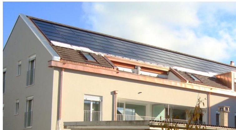
Abbildung 5, PV-Anlage im Dach integriert
