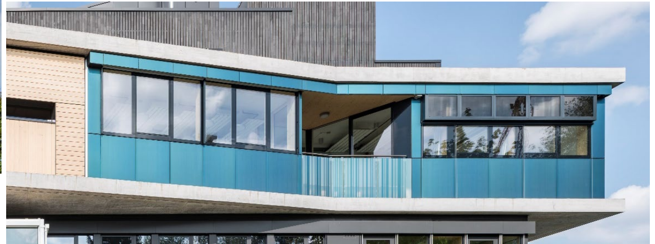
Solace: das Maximum aus der Fassade. Ohne Dach-PV Energie-neutral übers Jahr.
