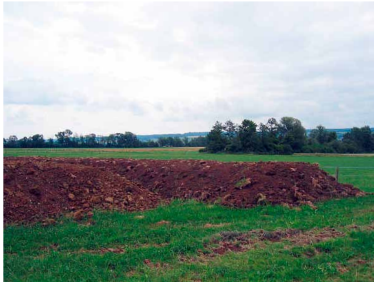
Zwischenlager von Ober- und Unterboden.
