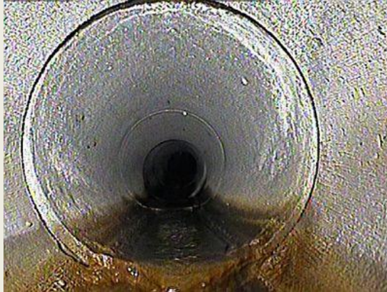
Foto 7: Breite Rohrverbindung
