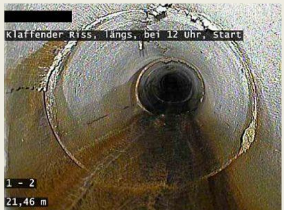
Foto 6: klaffender Riss, längs, bei 12 Uhr
