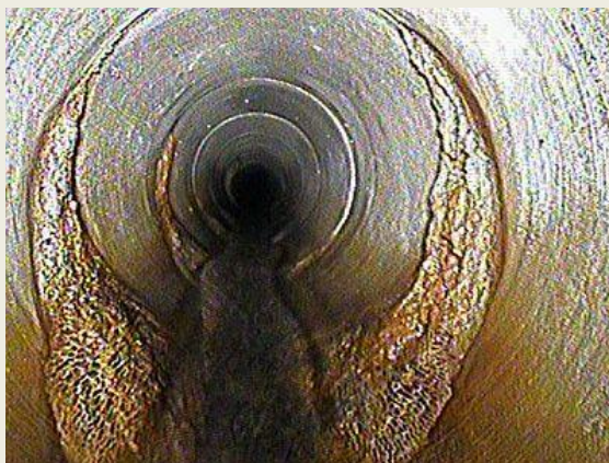
Foto 18: geringe Inkrustation an Rohrstößen
