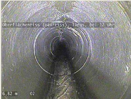
Foto 1: Oberflächenriss (Haarriss) bei 12 Uhr
