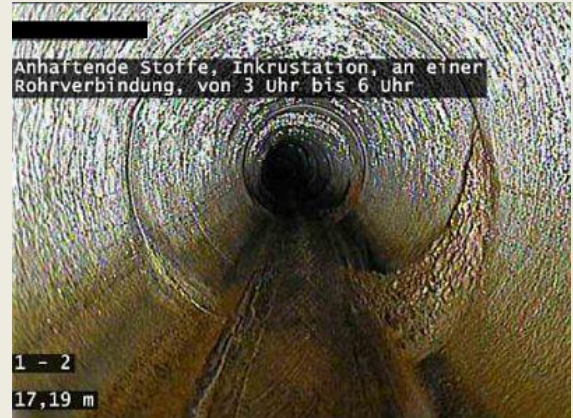
Foto 19: geringe Inkrustation an Rohrstößen
