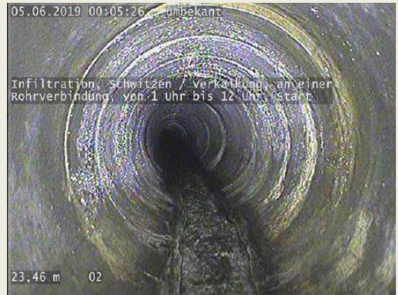
Foto 14: Schwitzen / Verkalkung von 1 bis 12 Uhr
