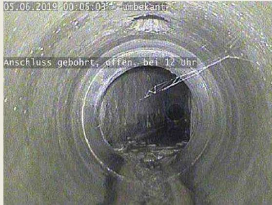
Foto 35: Anschluss bei 12 Uhr
