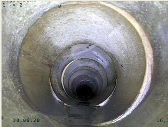
Foto 9: Versetzte Rohrverbindungen
