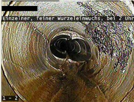
Foto 24: feiner Wurzeleinwuchs bei 2 Uhr
