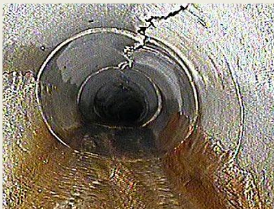
Foto 5: klaffender Riss, längs bei 12 Uhr
