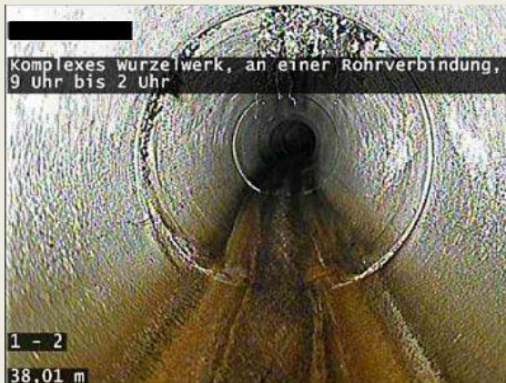
Foto 27: komplexes Wurzelsystem bei 9 bis 2 Uhr
