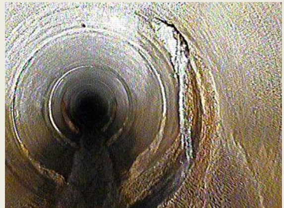
Foto 38: Anschluss bei 2 Uhr mit fließendem Wasser
