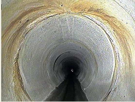
Foto 13: Kalk bei 7 bis 5 Uhr
