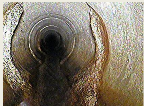
Foto 19: geringe Inkrustation an Rohrstößen
