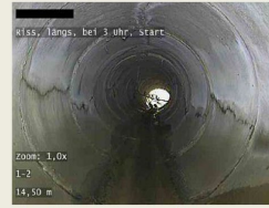
Foto 3: Risse, längs bei 3, 9 und 12 Uhr
