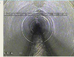
Foto 1: Oberflächenriss (Haarriss) bei 12 Uhr
