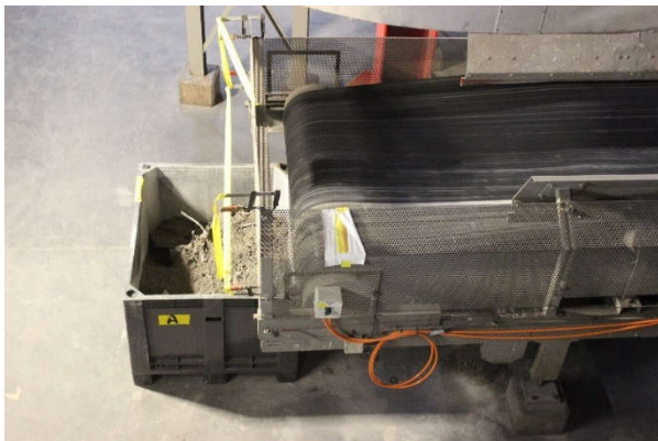
Abb. 11: Probenahme vom Kopfende eines Austragsbandes in eine Paloxe im Ofenhaus der Limeco.
