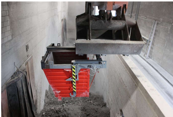
Abb. 12a und b: Probenahme am Abwurf des Schlackenbandes von Verbrennungslinie 1 der KVA Winterthur mit dem am Schlackenkran angehängten Probenahme-Container. links (a): Probenahmecontainer am Kran; rechts (b): während des Auffangens von Probenmaterial.
