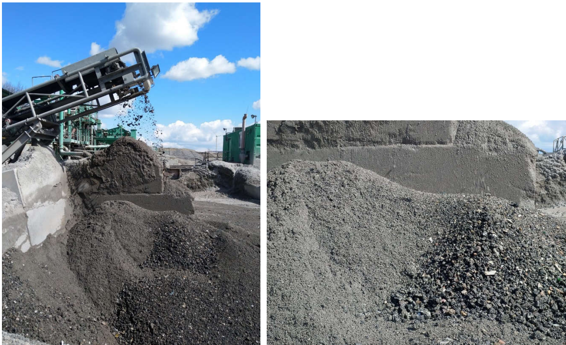
Abb. 108a und b: Bandabwurf von aufbereiteter Nassschlacke mit extremer Entmischung. Das Feinmaterial landet links "hinter" der Abwurfstelle, das grobe Material nimmt eine weitere Flugbahn. Gesamtsituation (linkes Bild), entmischtes Material an der Basis der Abwurfstelle (rechtes Bild).
