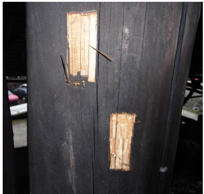
Abbildung 2: Es werden jeweils zwei bzw. mehrere Proben mit einer Schichtdicke von ca. 2-3 mm entnommen.
