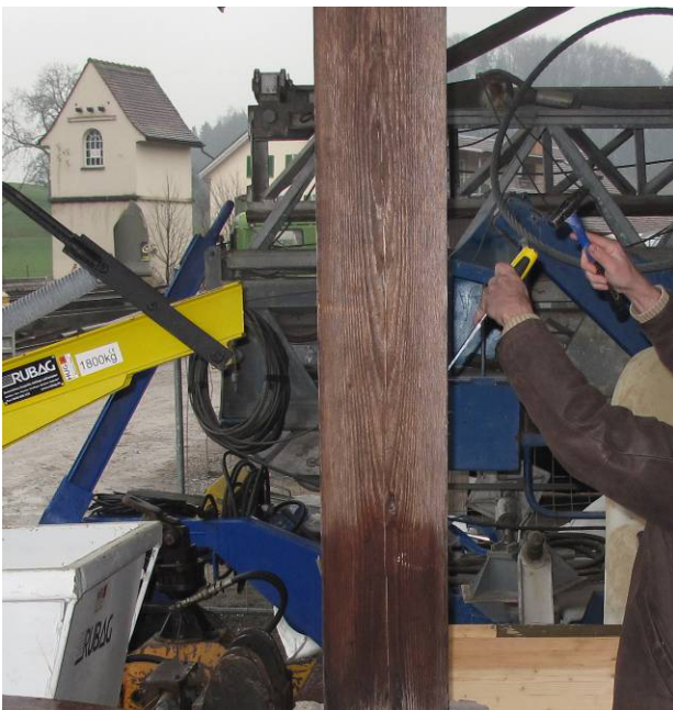
Abbildung 1: Probenahme an einem tragenden Holzbalken mittels Stechbeitel.
