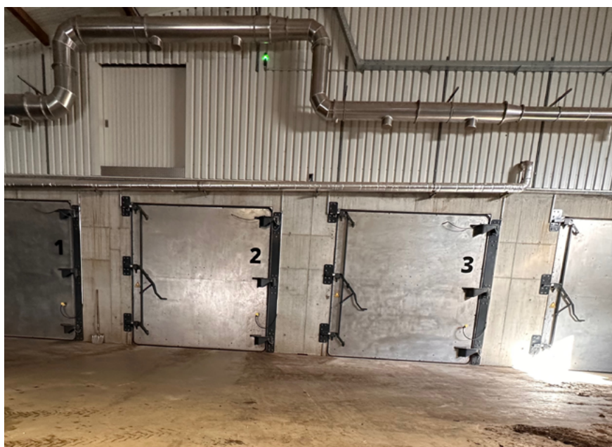
Foto 2: Die neue Boxenvergärung in Küsnacht, eine Renergon-Anlage, ist die erste Boxen-Vergärungs- anlage im Kanton; sie wird mit Radlader gefüllt und nach der Vergärung entleert, also als Batch betrieben.
