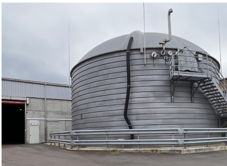
Foto 10: Lager für feste Produkte in der Halle und für flüssiges Gärgut im Nachgärer in Samstagern: Nach einer kurzen Sedimentierungsphase wird das noch warme flüssige Gärgut in den Nachgärer gepumpt, wo das weiter entstehende Biogas energetisch genutzt werden kann. Das entspricht dem aktuellen Stand der Technik.
