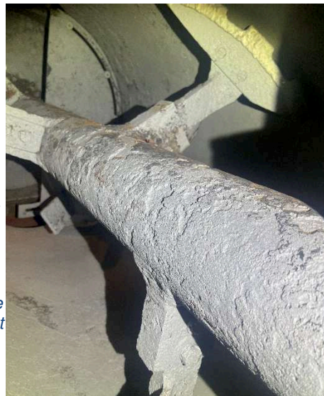
Abbildung 5 Rechts: Sandgestrahlte Mischer- welle des Paddelmi- schers. Dieser mischt die KSA mit 20% Was- ser unmittelbar vor dem Verlad auf den LKW. Die massive Stahlwelle weist deutlichen Verschleiss auf und muss 2027 er- setzt werden.
