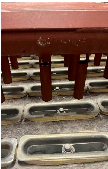
Abbildung 4 Links: Das Druckluft Abreini- gungssystem wurde mit neuen Düsen optimiert.
