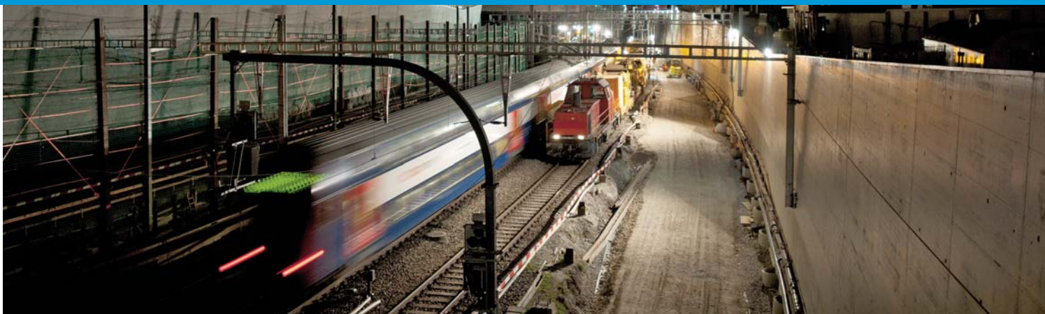
Grossbaustelle Durchmesserlinie: Sie verbindet die Bahnhöfe Altstetten, Hauptbahnhof und Oerlikon und bringt für den Hauptbahnhof Zürich die nötige Entlastung und weitere Fahrplanstabilität in der ganzen Schweiz.
