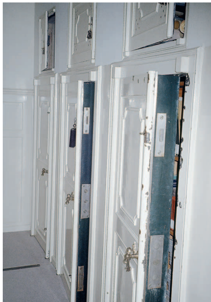
IV A 2: Zehntenurbar 1750 mit im Deckel eingebundenem gefaltetem Zehntenplan und: Die massiv in die Wände des 1867/68 erbauten Gemeindehauses eingelassenen Archivschränke.
